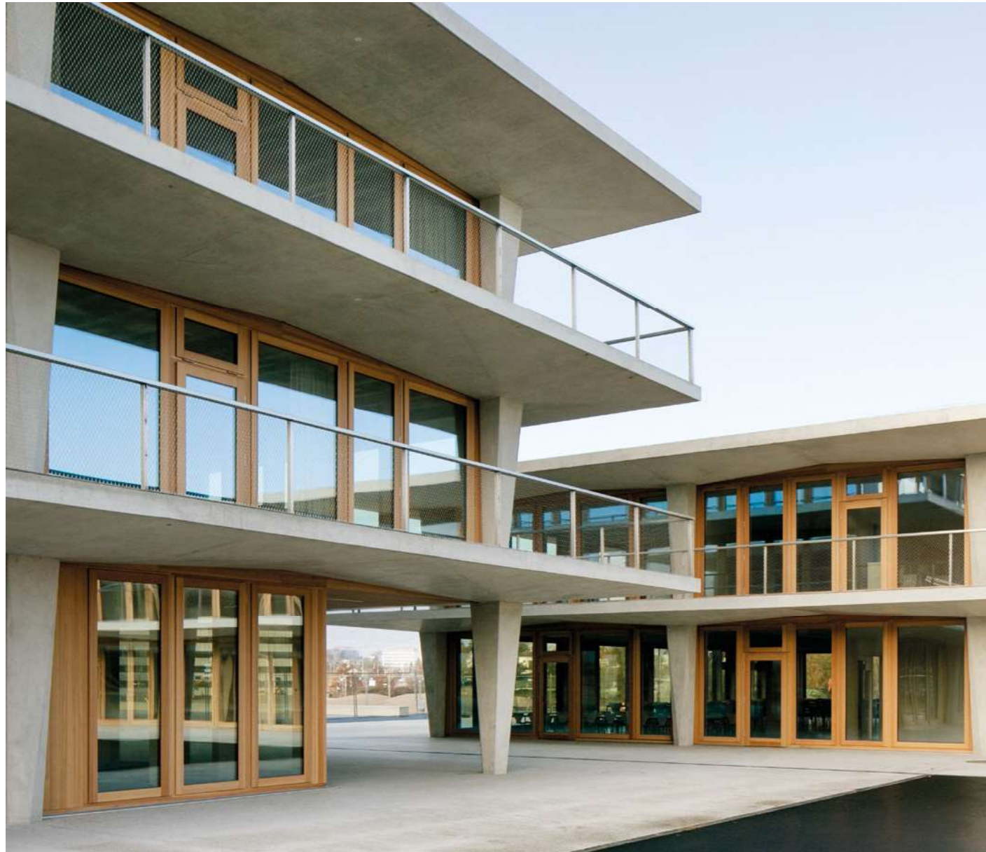
▲ Les consoles de l'exosquelette protègent l'enveloppe faite de menuiseries en mélèze.
