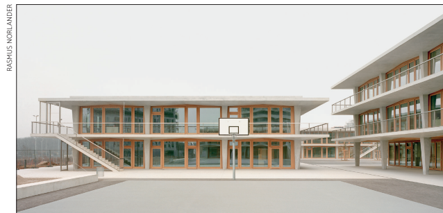
Le groupe scolaire des Vergers conçu pour résister aux tremblements de terre.
